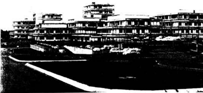
Abb. 1: Das Rechenzentrum ist seit Ende 1975 im naturwissenschaftlichen Verfügungsgebäude auf den Lahnbergen untergebracht.
